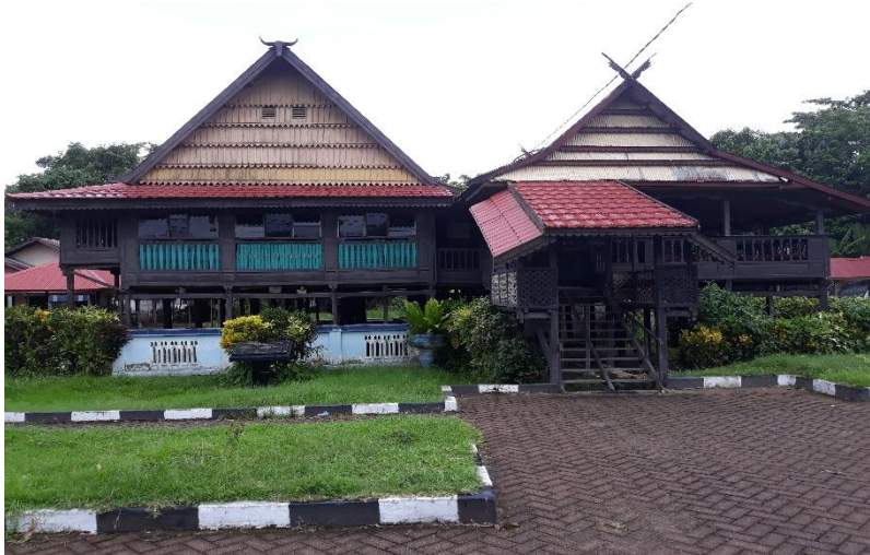
Gambar 2. Rumah balla lompoa Desa Galesong Baru Kecamatan Galesong Sumber: Dokumentasi Lapangan
