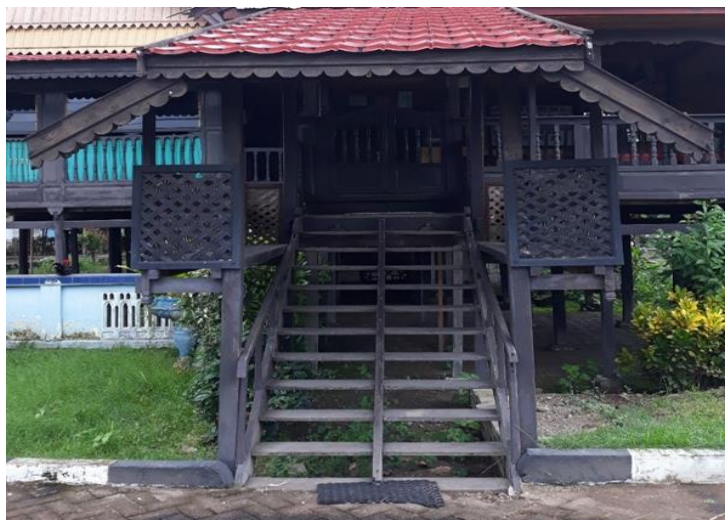
Gambar 3. Tampak depan Tangga Depan dengan Cocorang (pegangan) Sumber: Dokumentasi Lapangan
